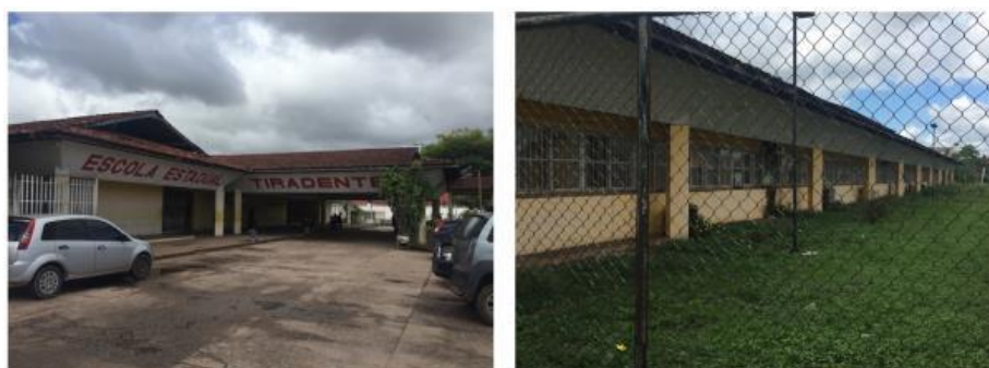
Figura 09: Fachada Principal e Fachada Lateral da Escola Tiradentes; Fonte: Autores, 2017.
