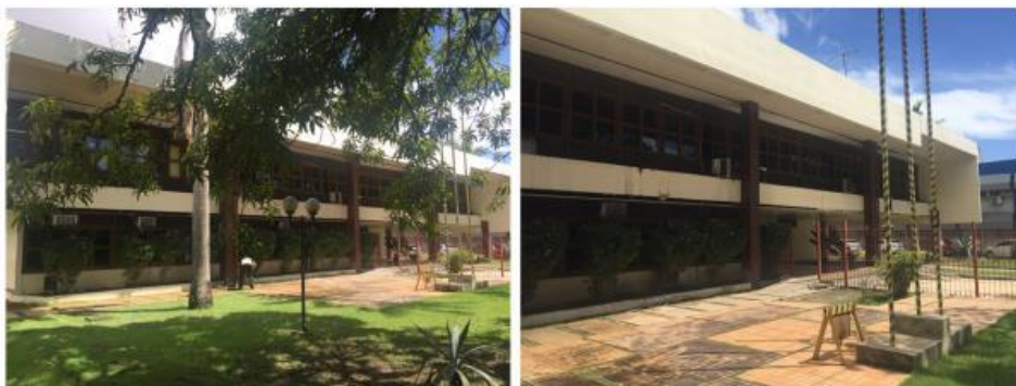
Figura 06: Fachada principal - SEINF/AP; Fonte: Autores, 2017.
