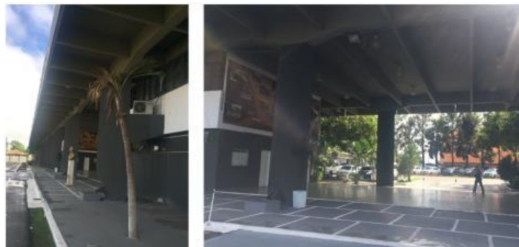
Figura 04: Elementos estruturais na composição do Batalhão da Polícia Militar; Fonte: Autores, 2017.
