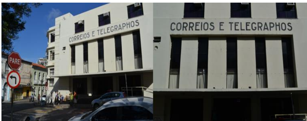
Figura 02. Fachadas dos Correios e Telégrafos. Fonte: Larissa Mota, 2014.
