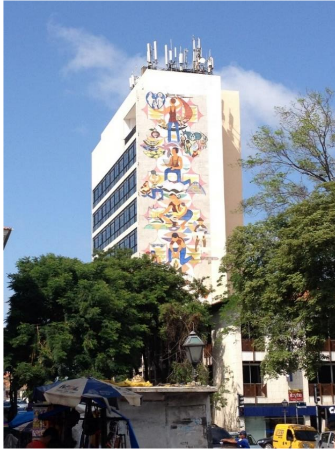
Figura 09. Fachada lateral, Banco do Estado do Maranhão. Fonte: Larissa Mota, 2014.
