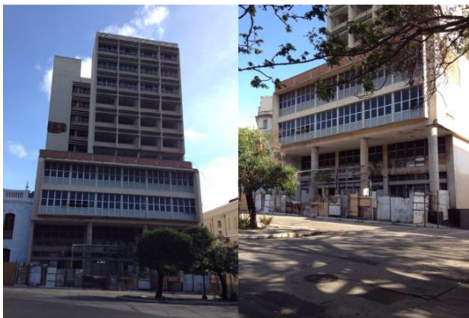
Figura 07. Fachadas e detalhes do edifício João Goulart. Fonte: Larissa Mota, 2016
