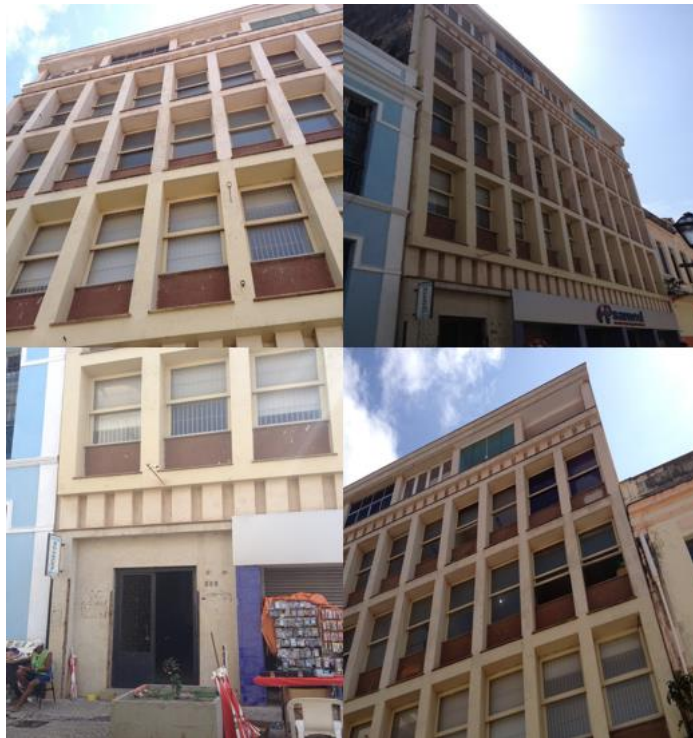
Figura 05. Fachadas e detalhes do edifício Sulacap. Fonte: Larissa Mota, 2016.
