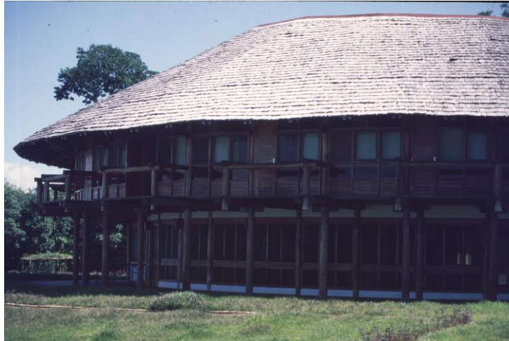
Figura 10: Fachada da nave principal do Hotel dos Guanavenas. Fonte: Acervo Severiano Mário Porto.
