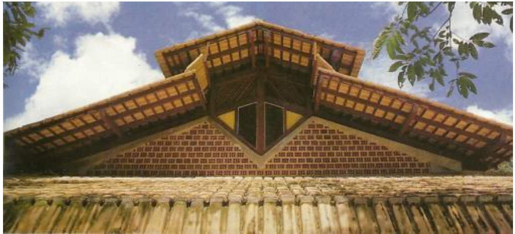
Figura 9. Telhado com lanternim e beirais no Retiro Tagaste. Fonte: Revista Projeto nº102.
