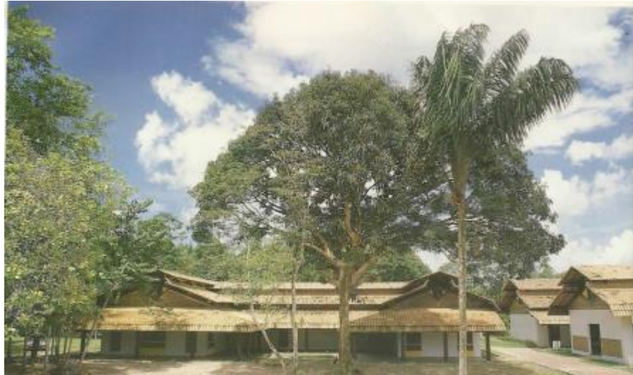
Figura 5. Panorama das edificações do Retiro Tagaste. Fonte: Revista Projeto nº102.
