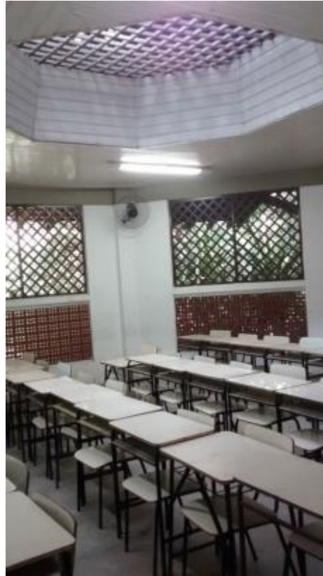
Figura 1. Interior de sala de aula na Escola Bosque com forro de madeira, muxarabis e aberturas com tijolo invertido, que permitem ventilação constante. Fonte: Arquivo pessoal.
