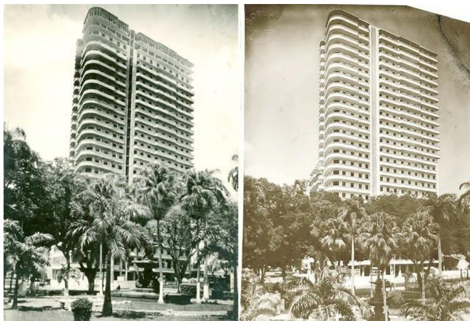
Figura 4: O segundo bloco em construção e em fase de finalização. Fonte: Acervo da Família Pinto da Silva.
