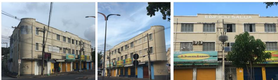
Figura 09. Fachadas do Edifício Saluá. Fonte: Autora, 2016.
