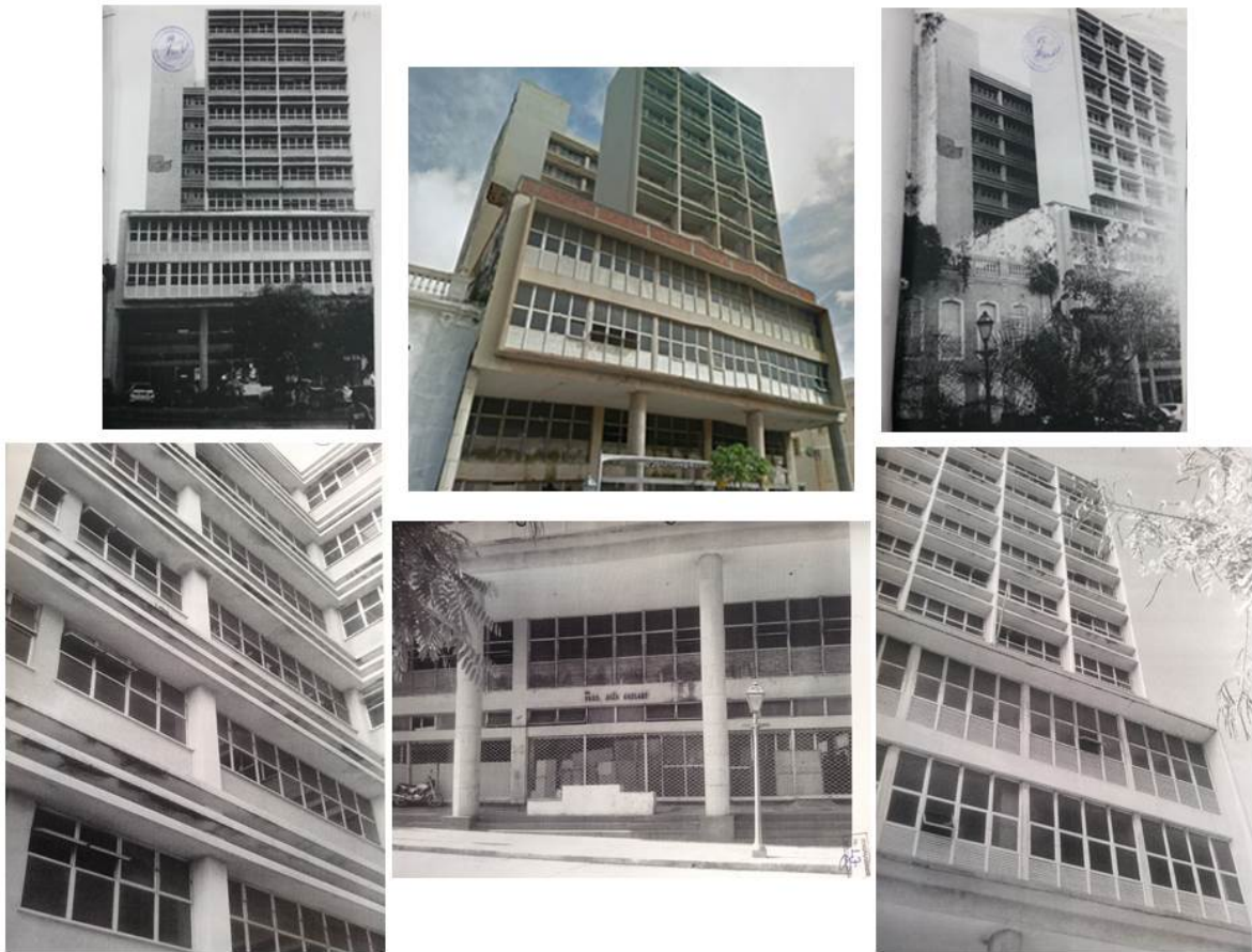
Figura 08. Fachadas do Edifício João Goulart. Fonte: IPHAN, 2009, INSS, 2008 .
