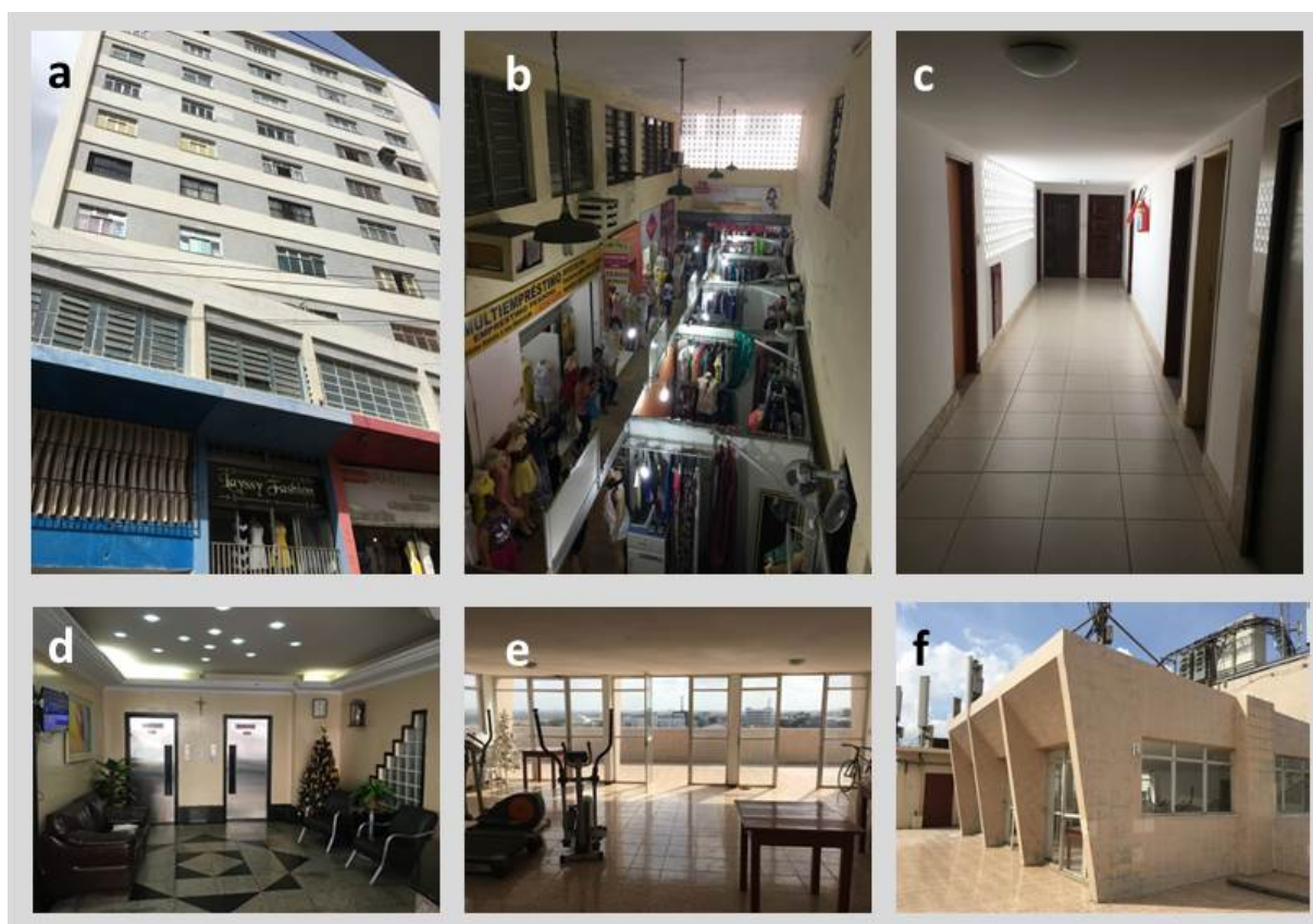
Figura 03. Vistas do Edifício Caiçara: Fachada (a), Lojas (b), circulação apartamentos (c), recepção (d), salão de festas (e) e terraço (f). Fonte: Lúcia Nascimento, 2016.
