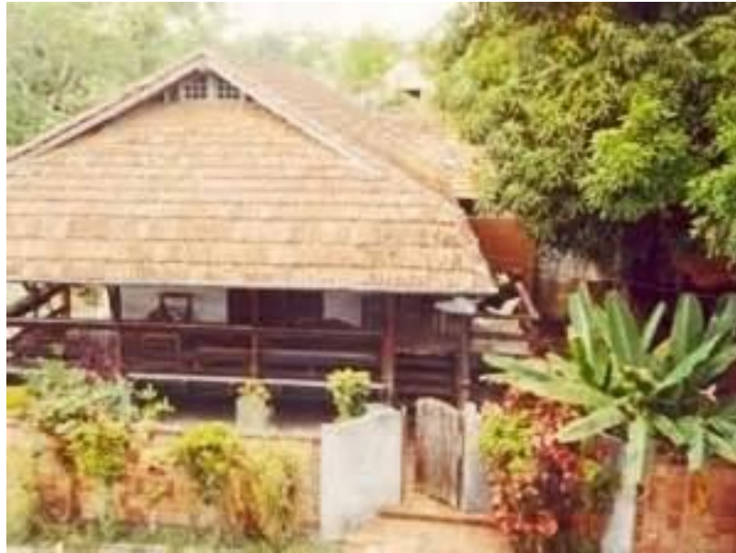
Figura 03 - Residência do Arquiteto Milton Monte
