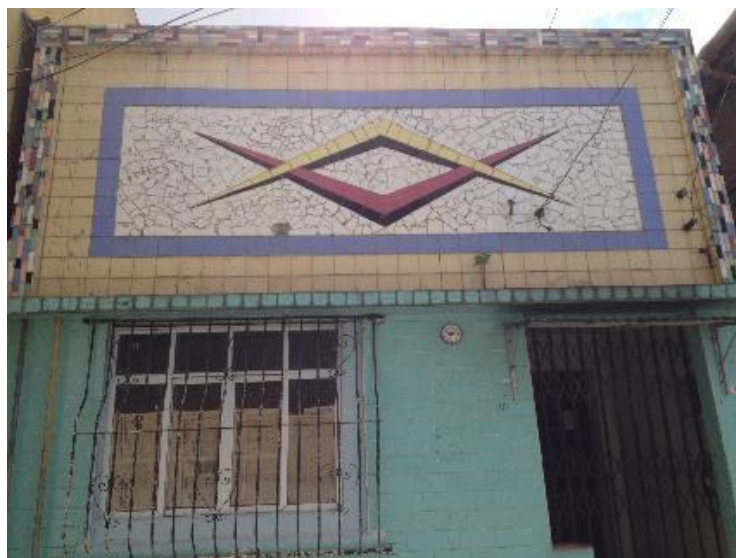
Figura 8 – Fachada da Residência nº 40, na Passagem Maria Luiza.
