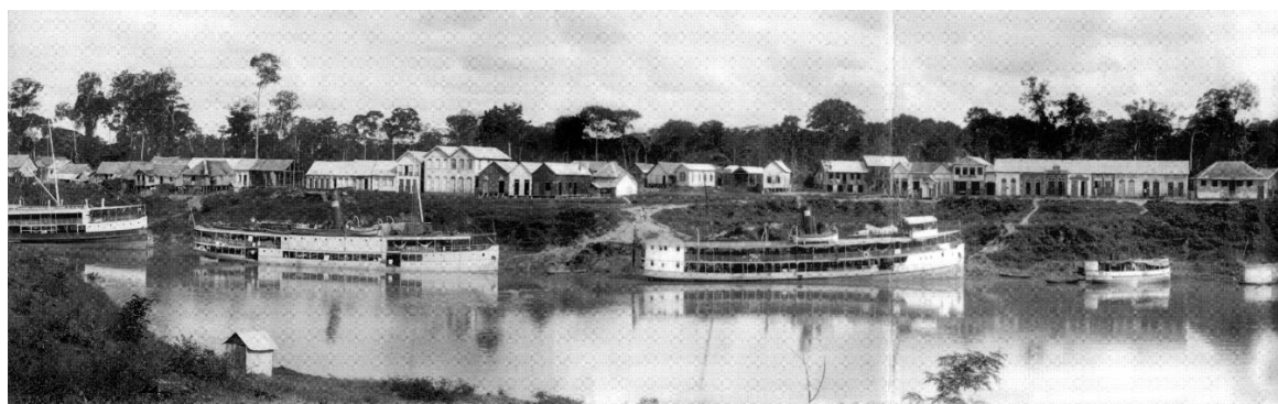
Figura 02 –Edificações em madeira beneficiada, fachadas variadas e cobertura de fibrocimento. Fonte: Fundação Oswaldo Cruz/DPHC. Data: 1912.
